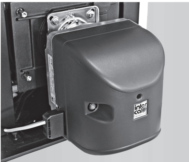
Abb. 4: Montierter Brenner
