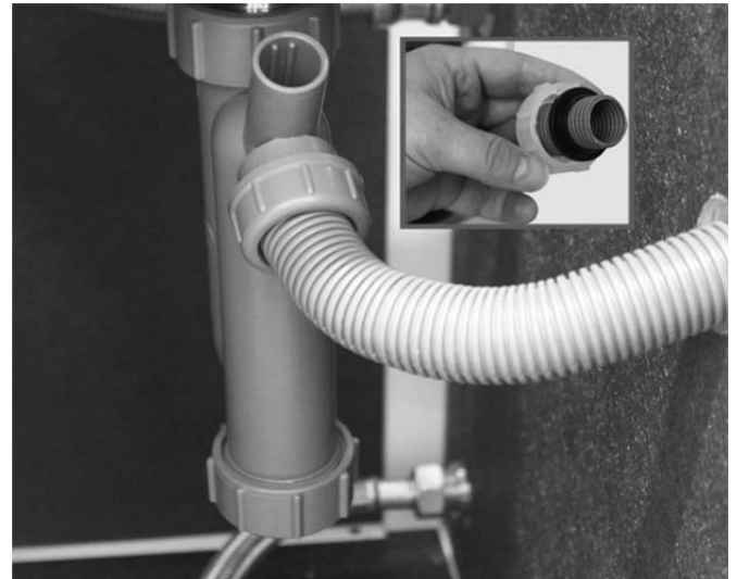
Abb. 16: Montage des Kondensatschlauchs
