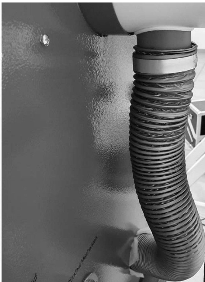
Abb. 12: Zuluftschlauch am Kesselabgasanschluss
