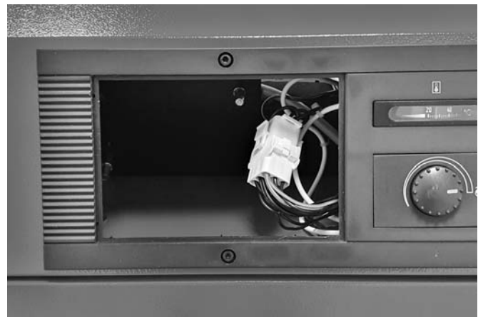
Abb. 29: Offener Reglerschacht mit Steckverbindung für den Regler-Kabelbaum.
