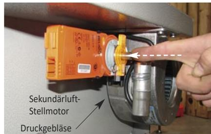
**i** Während des Betriebs wird stündlich ein automatischer Positionsabgleich des Stellmotors durchgeführt (Kalibrierung: auf 100%, Endanschlag der Luftblende)
