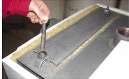
2 Lösen der Wärmetauscherabdeckung (13er Gabelschlüssel).
