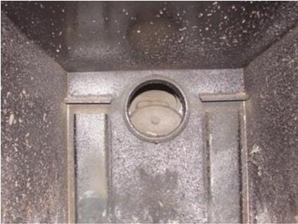
Vergaserkammer (Füllraum) nach einigen Tagen Heizbetrieb. Die Teerbildung ist völlig normal und wird immer wieder mit abgebrannt.
