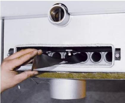
Die mitgelieferten Turbulatoren werden, wie in der Abbildung ersichtlich, in die Abgaswärmetauscherrohre eingesetzt.
